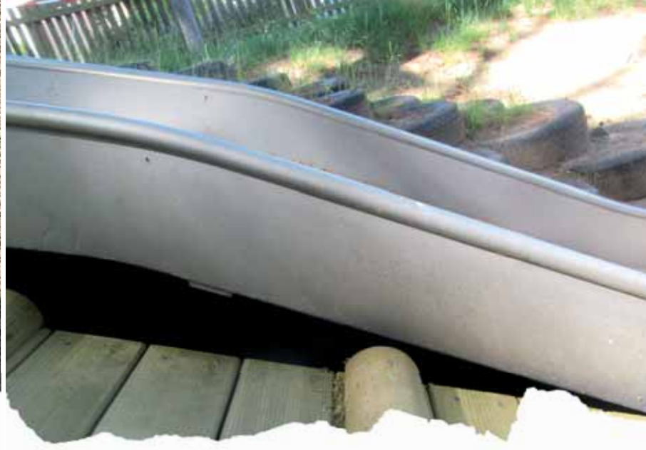
Foto links: Wellenrutsche mit gerader Rampe – Fangstelle vom Hersteller, Foto rechts: Auslauftteil mit Fangstelle – gebaut vom Betreiber /// Photo left: Wave slide with straight ramp - entrapment from the manufacturer; photo right: run-out part with entrapment - built by the operator
