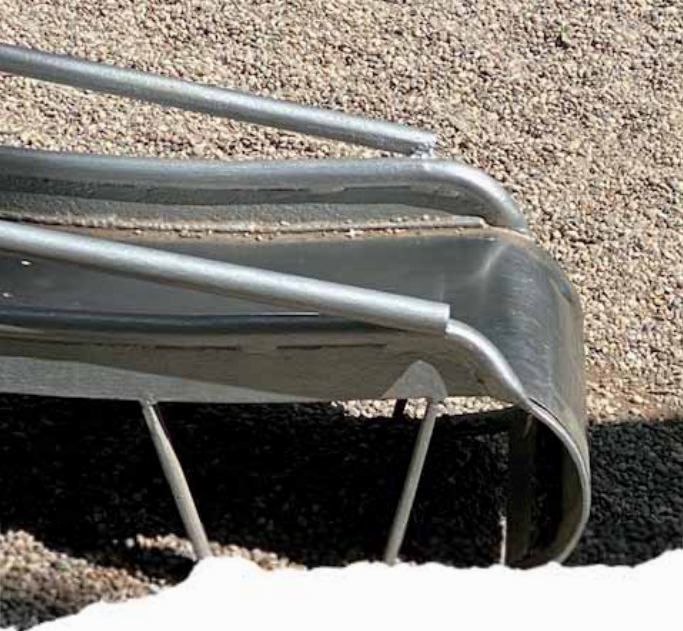
Foto links: Wellenrutsche mit gerader Rampe – Fangstelle vom Hersteller, Foto rechts: Auslauftteil mit Fangstelle – gebaut vom Betreiber /// Photo left: Wave slide with straight ramp - entrapment from the manufacturer; photo right: run-out part with entrapment - built by the operator
