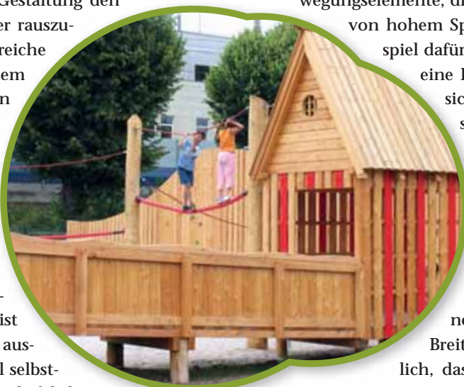
Foto Mitte: Dieser zweistöckige Spielraum bietet einen barrierefrei erreichbaren und darüber einen mittels Seilen erreichbaren Rückzugsraum (ASO Amstetten)
