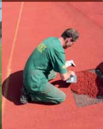
Kunststoffbodenreparatur
